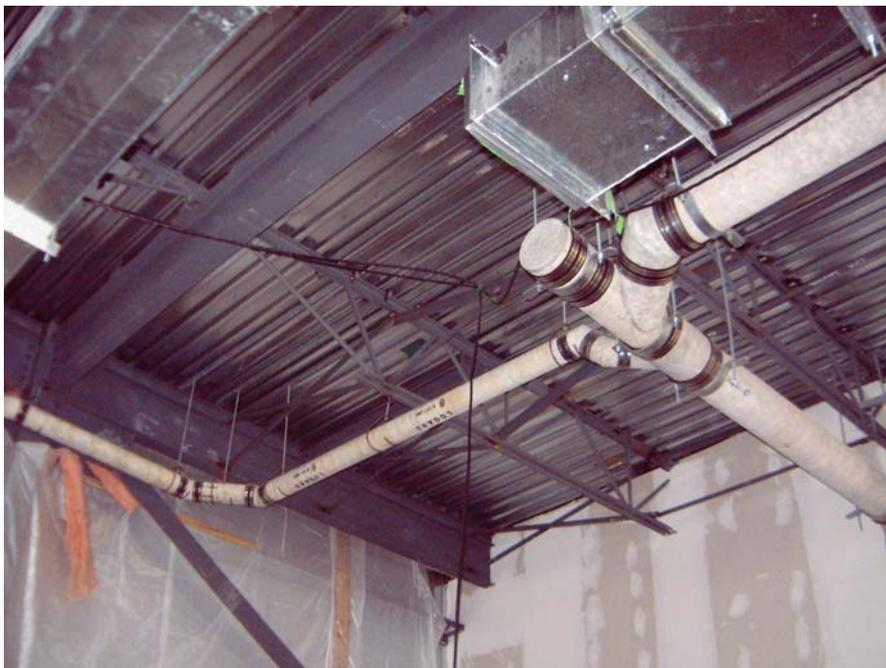
bryant que le bruit généré par le même débit d'eau dans un tuyau de fonte du même diamètre. Un tuyau de PVC aurait eu besoin d'un isolant acoustique de 1 po pour obtenir le même résultat. Cette qualité est particulièrement recherchée dans les tuyauteries des immeubles d'habitation ou de bureaux.
